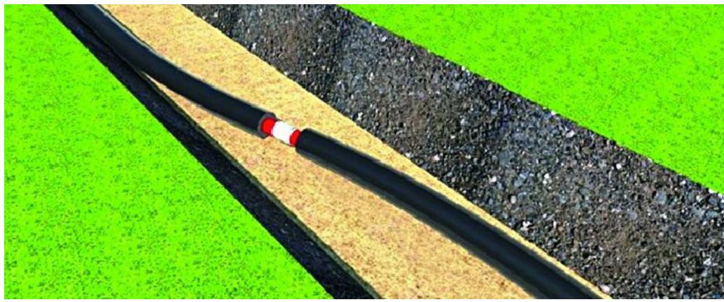
Правильно. Вариант 2. Прокладывать трубы изначально с изгибом трубы от остаточной деформации в противоположные стороны.
